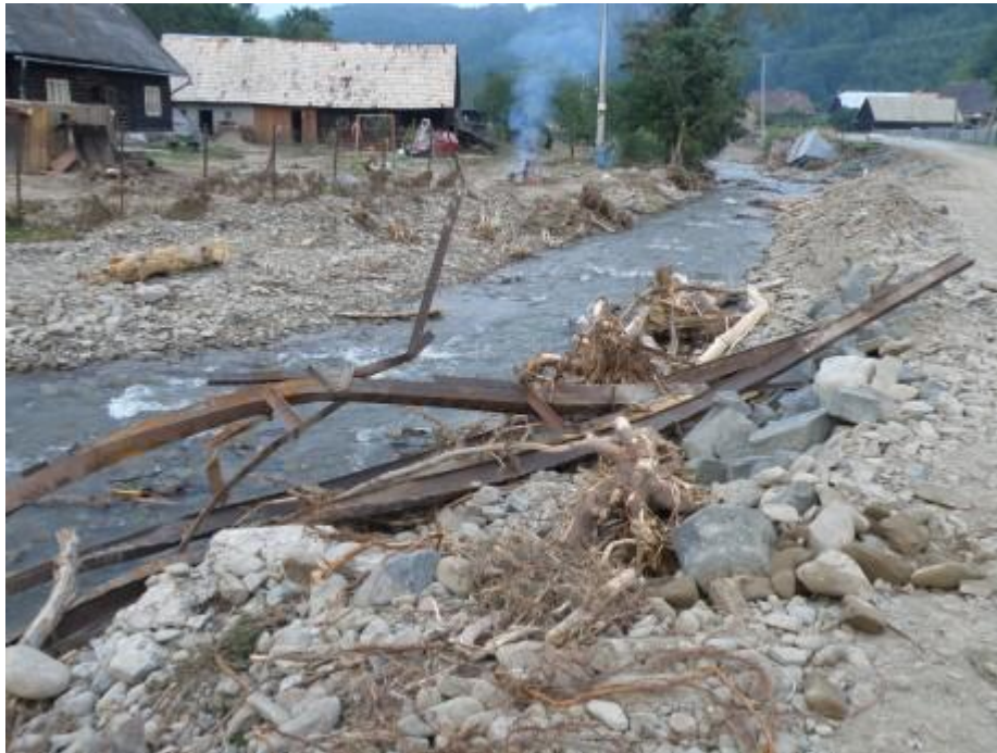
Obrázok 4 Poškodená časť centra Livova po opravách [17].
