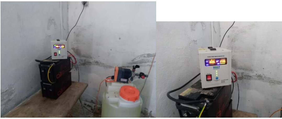
Záložné akumulátory a sínusový zdroj, zároveň aj simulovaný výpadok EE
